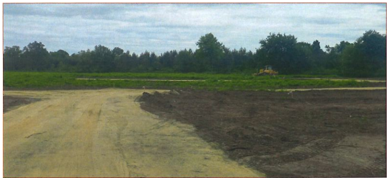
Une centrale solaire sur la commune | Lancé en février 2017, le projet de centrale solaire au sol sur 16 hectares au nord de la commune commence à sortir de terre. Sa mise en service est prévue courant 2026. Ce projet, mené conjointement avec la société Arkolia, est une avancée en énergie renouvelable pour notre commune et une bouffée d'oxygène pour nos finances.
